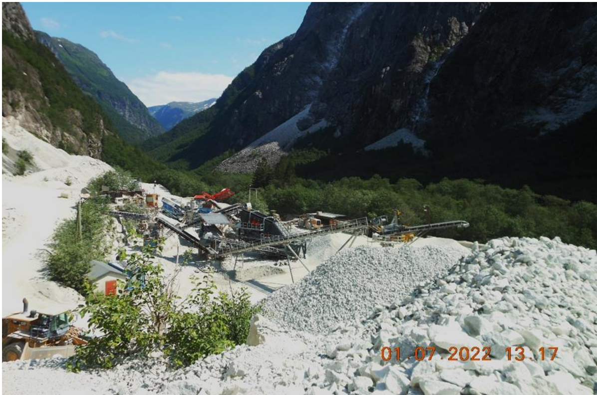
Figur 3. Steinknuseranlegget utenfor Holmen gruve i på verdensarvområdet. © IUCN / Susanna Lindeman
