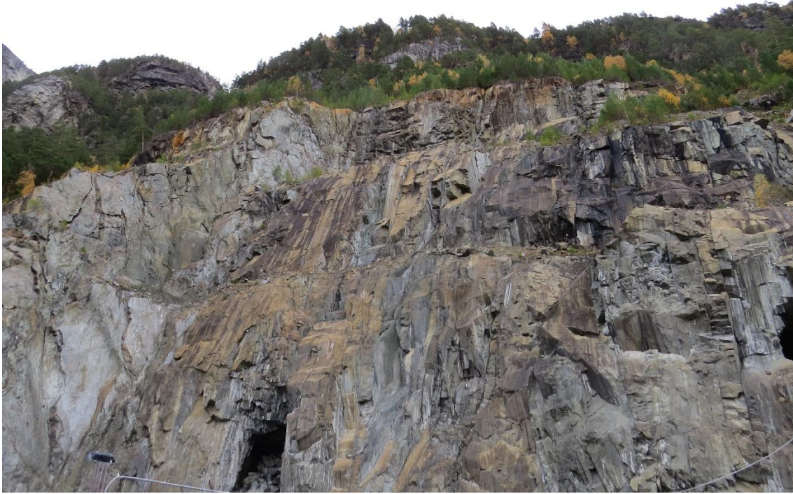
Figur 6-2: Foto som illustrerer sprekkdanningar i peridotitt ved Raudbergvika. Foto frå vest mot aust. Foto: COWI AS.
